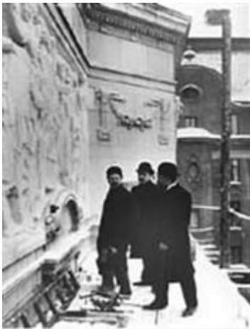
Arbete med fris på Dramatens fasad. Eriksson är mannen till vänster
